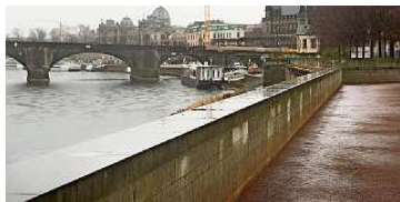
Insgesamt 3,6 Kilometer lang sind die Mauern, wie am Landtag, und Wälle, die die Innenstadt schützen.
